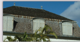
Comble Maison de Villiers, cliché Pascal Laude
